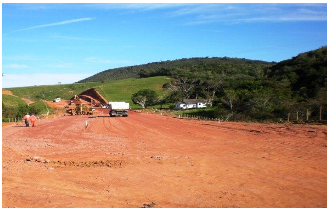
Obras de execução do Cotorno Rodoviário. Fonte: (SEMPEDA)
