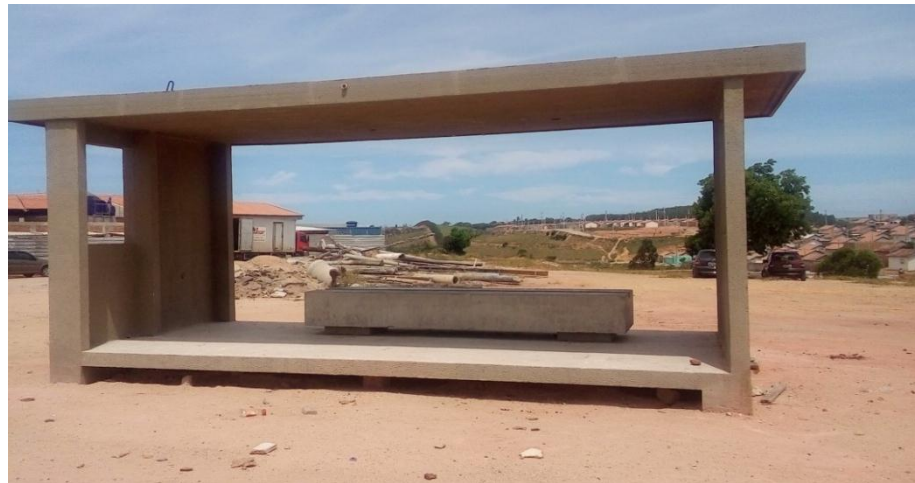
Novo Ponto de Ônibus em execução
